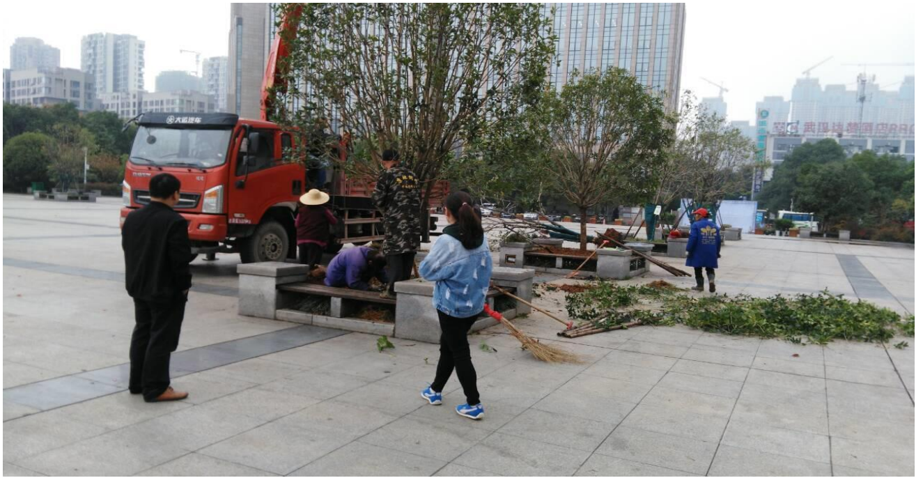
更换广场树木
