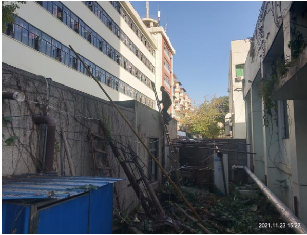
二次供水安全检查
