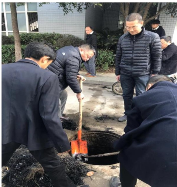
紧急疏通下水管道
